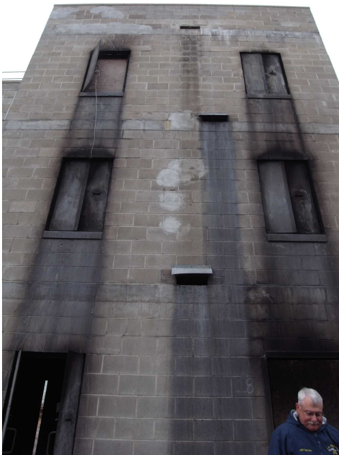
大規模火災消火訓練棟
